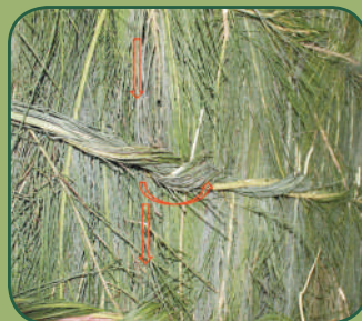
Veo con sentido do atado vertical. O trenzado horizontal só engadindo veos por baixo
