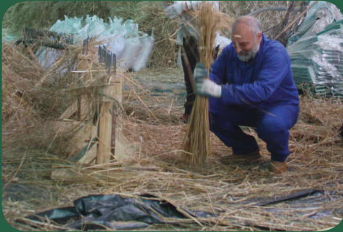
Fig. 7: Paletando o puñado de palla para detectar as pallas rotas, dobradas ou cortas, por membros da Asociación de Propietarios de Teitos de Palla.
