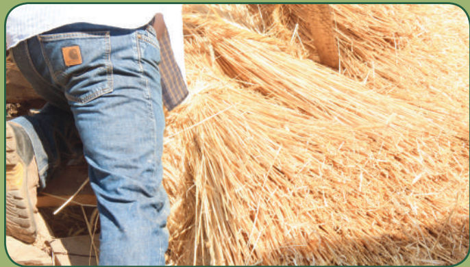
Colocación da palla por riba das manadas que van atadas o teito. Obsérvese que o brincallo so vai por riba. Teitado de Horreo en Valgos, Cervantes no setembro de 2012.
