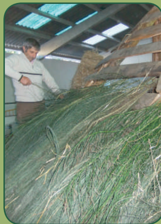
Colocación de xesta para crear a broza na estrutura do teito
